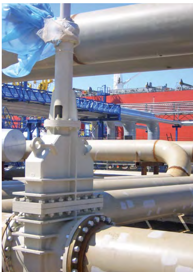
Монтаж задвижек – Усть-Луга, Россия / Installation of the gate valves – Ust-Luga, Russia
